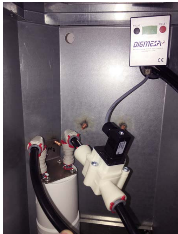
Bild 1: Filterkartusche (links unten) mit Durchflusssensor (weiß) mit Alarmierungsmodul (Digimesa)
